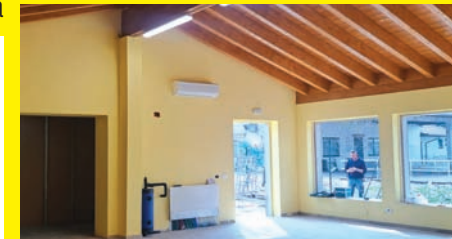
Completo lavori mensa della scuola d'infanzia
